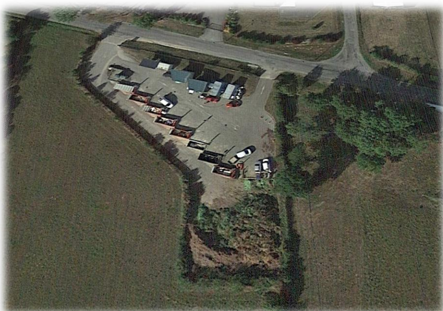
Vue aérienne de la déchetterie de Val d'Anast
